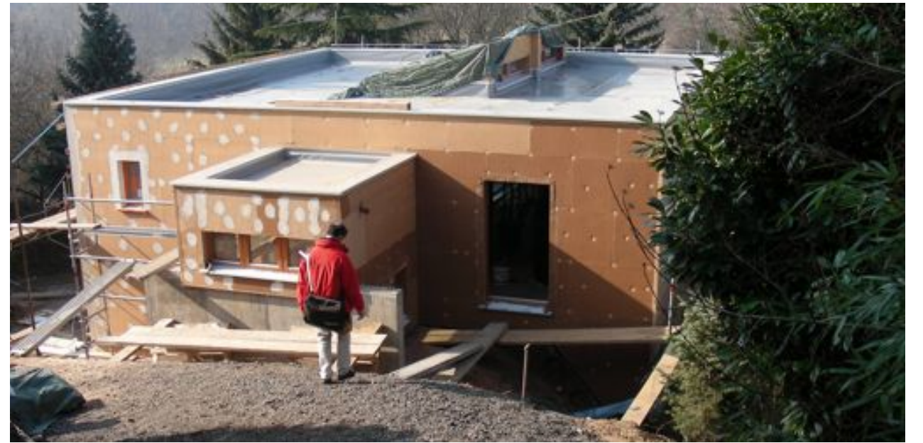
Pose de l'isolation par l'extérieur en panneaux de fibre de bois
