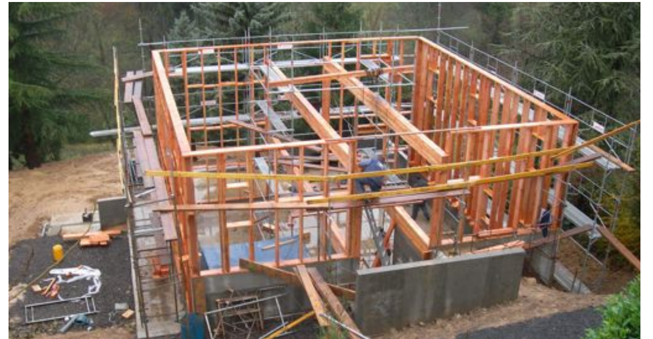
Pose de l'ossature bois
