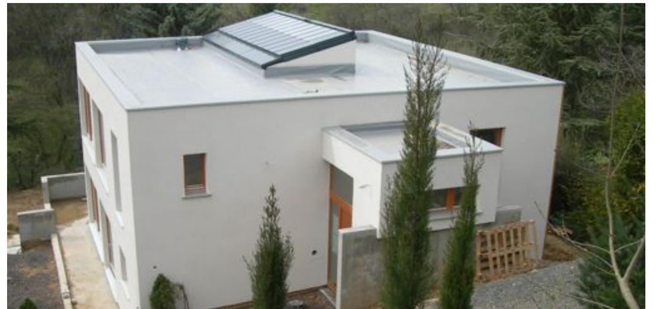
Pose de l'enduit
